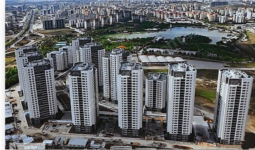
Göksupark Evleri Oyak İnşaat
